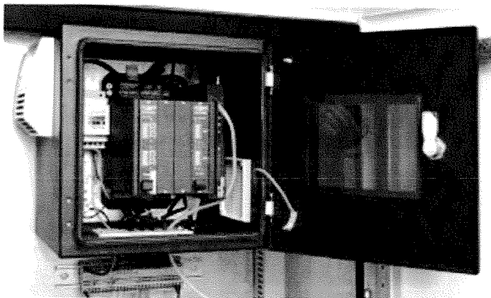
2. Widok wnętrza szafki zewnętrznej SZA IP55
